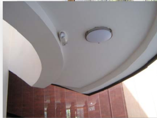
FOTOGRAFÍA No.24 AÍDA FIGUEROA 2010, MUESTRA EL TRATAMIENTO DE TECHOS DE INTECAP
