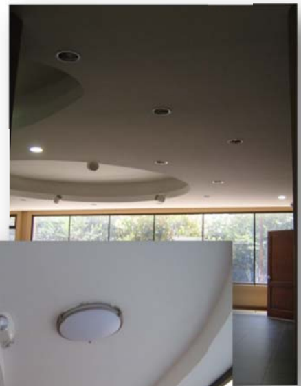
FOTOGRAFÍA No.22 AÍDA FIGUEROA 2010, MUESTRA EL TRATAMIENTO DE TECHOS DE INTECAP
