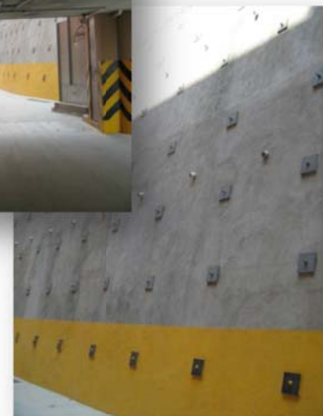
FOTOGRAFÍA No. 18 AÍDA FIGUEROA 2010, MUESTRA EL MURO DE CONTECNIÓN QUE HAY EN EL COMPLEJO DE INTECAP
