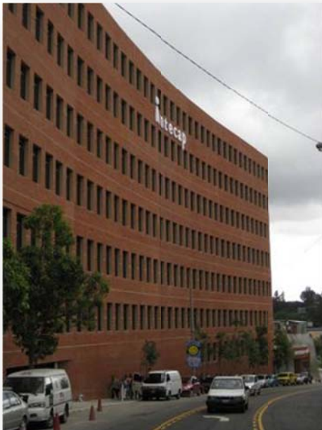
FOTOGRAFÍA No. 16 AÍDA FIGUEROA 2010, MUESTRA LA FACHADA FRONTAL DE INTECAP
