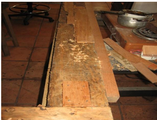
Reposición de material y aplicación de capa pictórica en marco
