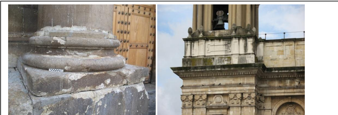
Detalles fachada de Catedral Metropolitana.
