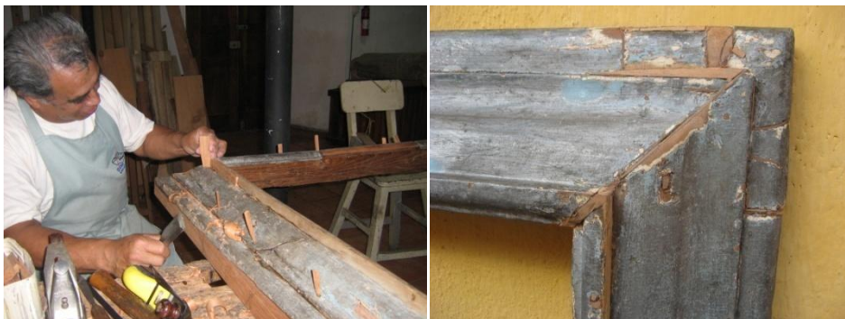
Bloqueo de grietas e injertos en un marco.
