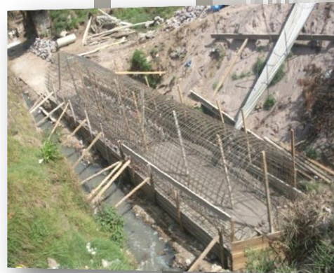
Fotografía 34, Proyecto de entubado de aguas negras en la actualidad ya culminado, San Juan Ostuncalco, Quetzaltenango
