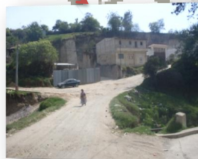
Vista 6: Puente que se pretende mejorar en el caserío Agua Tibia, que pasa frente al terreno en estudio
