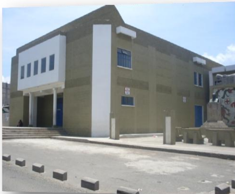
Fotografía 53, Construcciones actuales en el casco urbano de San Juan Ostuncalco, Quetzaltenango
