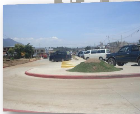
Fotografía 39, Terminal de buses de San Juan Ostuncalco, Quetzaltenango
