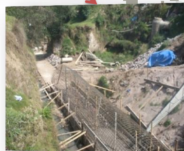
Vista 4: Proyecto en ejecución de entubado de aguas negras, colindante al terreno de estudio.
