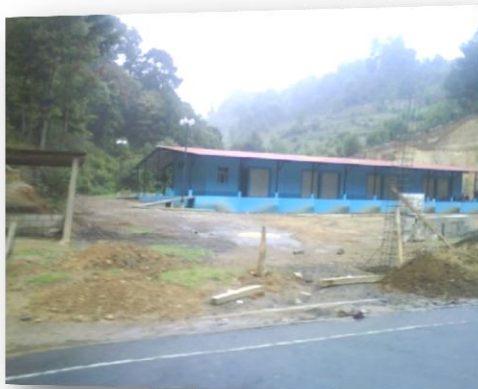
Fotografía 59, Centro de Acopio para papa, ubicado en la cumbre, carretera a San Marcos
