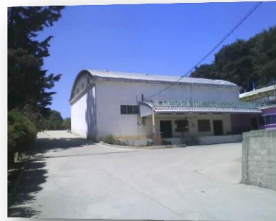
Vista 9: Salón que se demolerá en el terreno, para optimizar el área del terreno.
