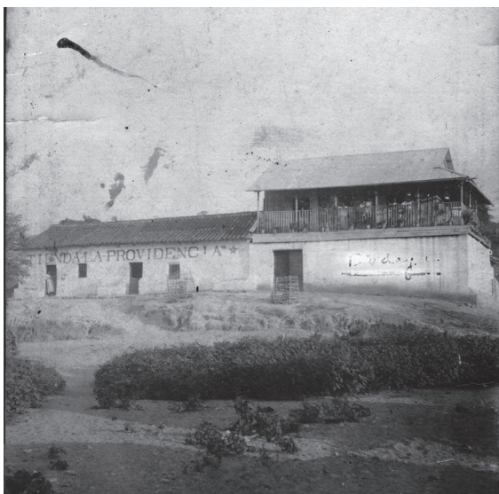
Fotografía de la vivienda Barrientos Morales en El Rancho, el 1 de agosto de 1917. Una fuente de gran importancia para un proyecto de restauración.
