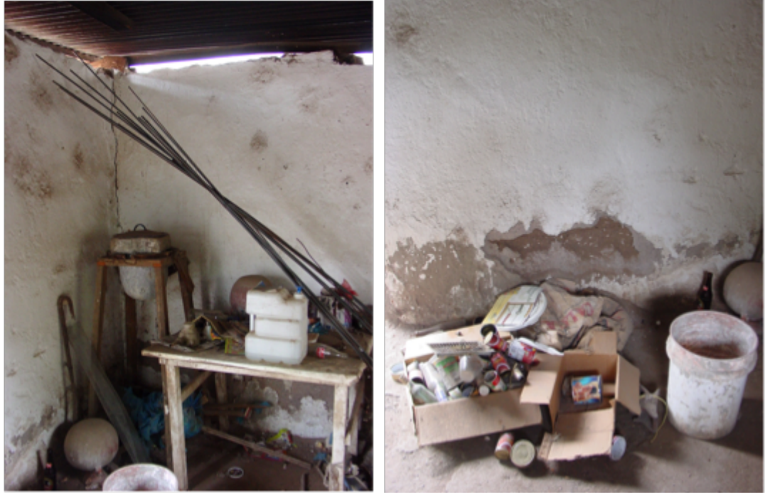
Objetos depositados en la cocina.
