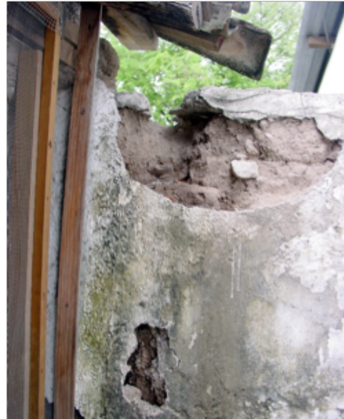
Muro oriental, entre el comedor y la cocina
