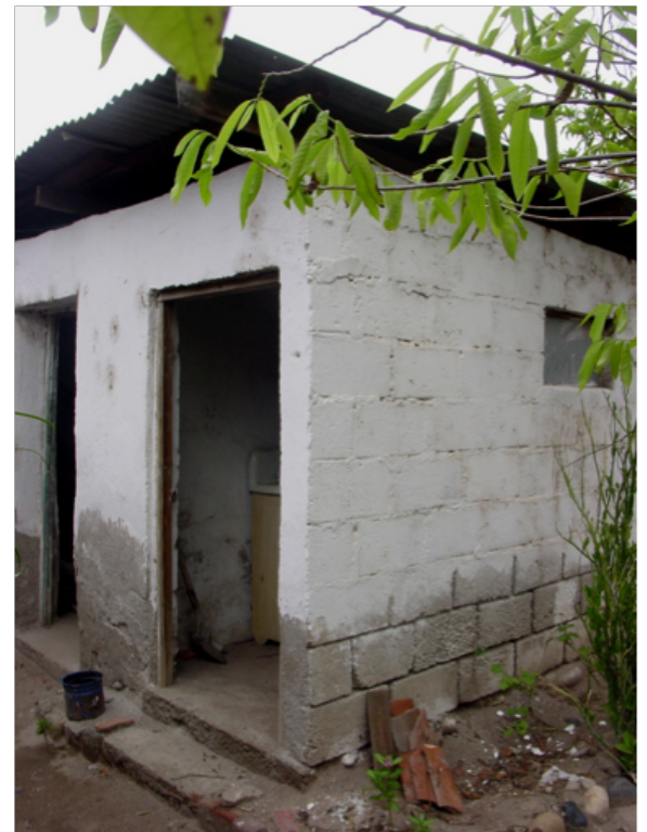
Vista frontal del baño, con blocks de cemento expuestos.
