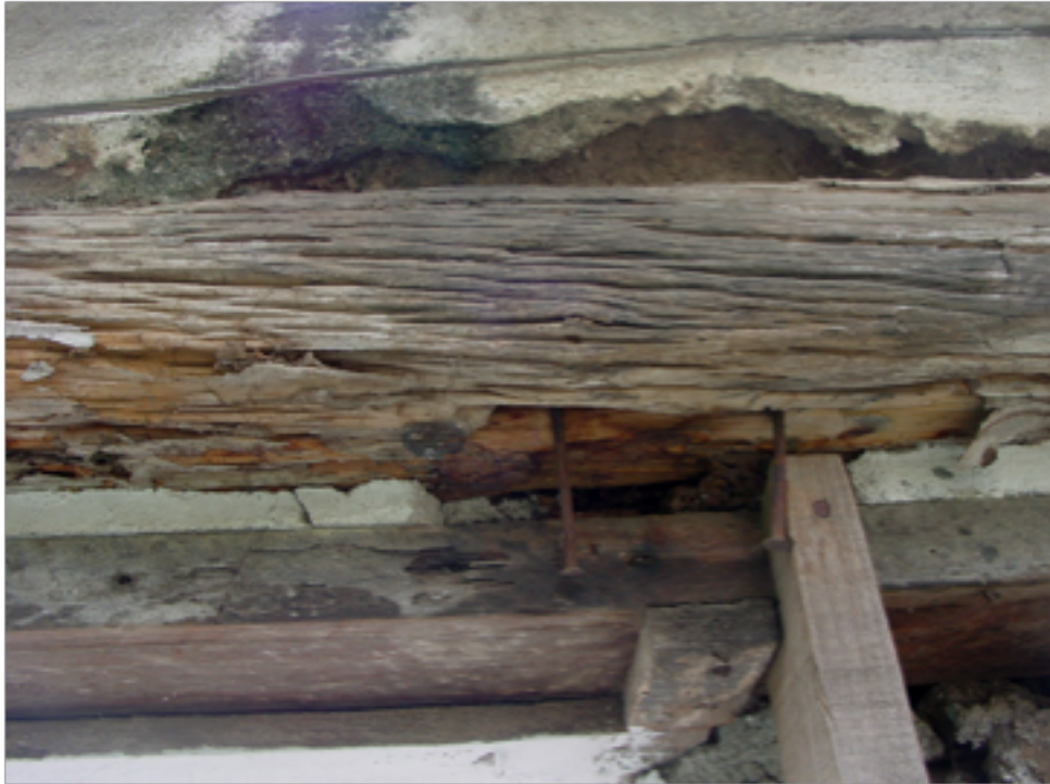
Dintel en la entrada al patio.
