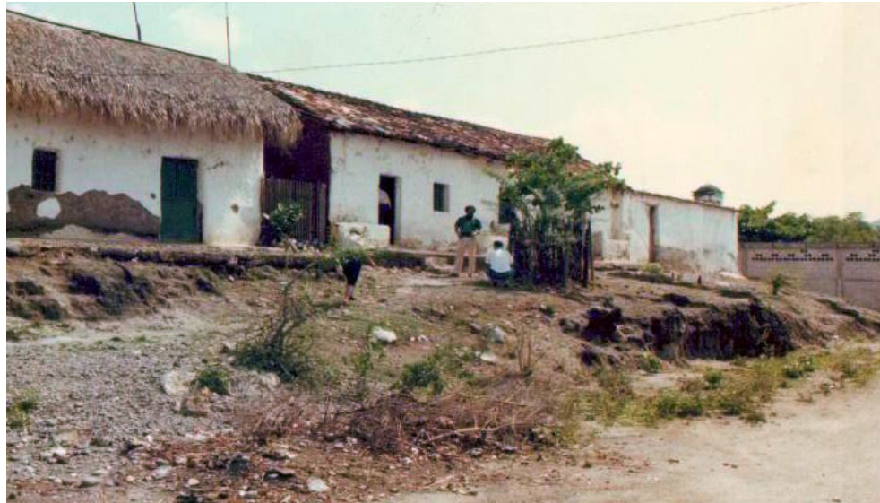
La vivienda Barrientos Morales poco antes del terremoto de 1976. Obsérvese la casa de la izquierda, propiedad de la familia Barillas, de techo de palma y que fue destruida por el sismo.
