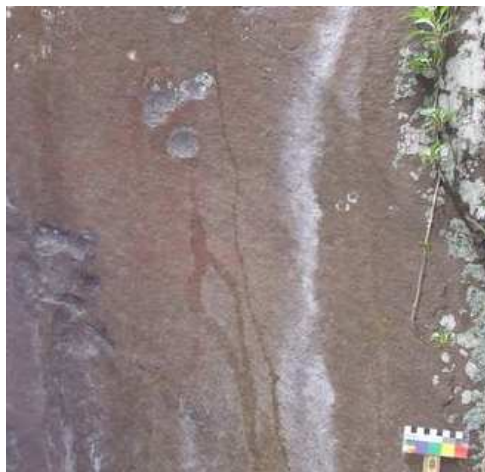
Figura 28: Impactos de balas sobre una pintura
