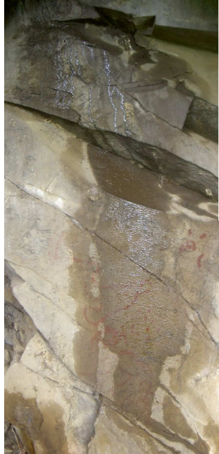
Figura 58: Vista de un escurrimiento en el área D en julio 2008
