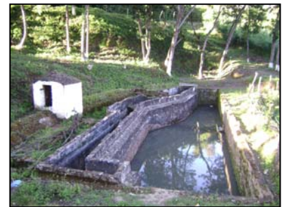
Acueducto "Las Tomas"
