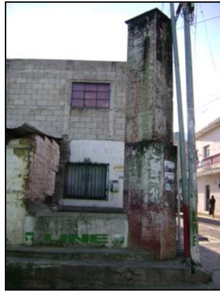
Pila y acueducto "La Cantarilla" Zona 4 Comalapa. Siglo XVII.
