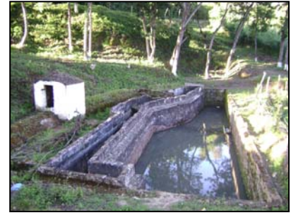
Acueducto "Las Tomas" zona 1 del Siglo XVII.
