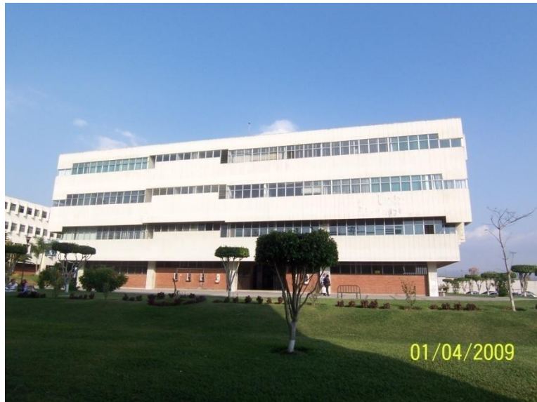
Gráfica No. 11 Vista del Edificio D
