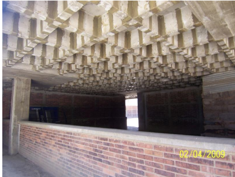
Gráfica No. 24 Edificio en construcción
