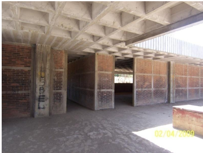
Gráfica No. 25 Edificio en construcción
