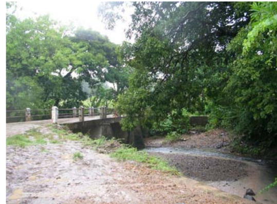
10 puente hacia potrero grande sobre el río calera fuente: elaboración propia
