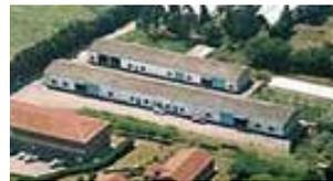
El área de bodega y laboratorios tiene como prioridad la horizontalidad de la edificación, con ventanas cuadradas a una altura de 1.20mts sobre el nivel de piso, las cuales muestran un patrón repetitivo. Esta edificación posee techo en dos aguas de lámina y muros de block.
