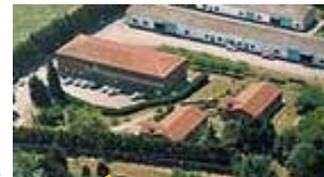
El área de aulas de formación y biblioteca posee dos niveles, ventanas cuadradas manteniendo una simetría vertical, orientadas Norte Sur. La edificación es de ladrillo y techo de cuatro aguas de teja.
