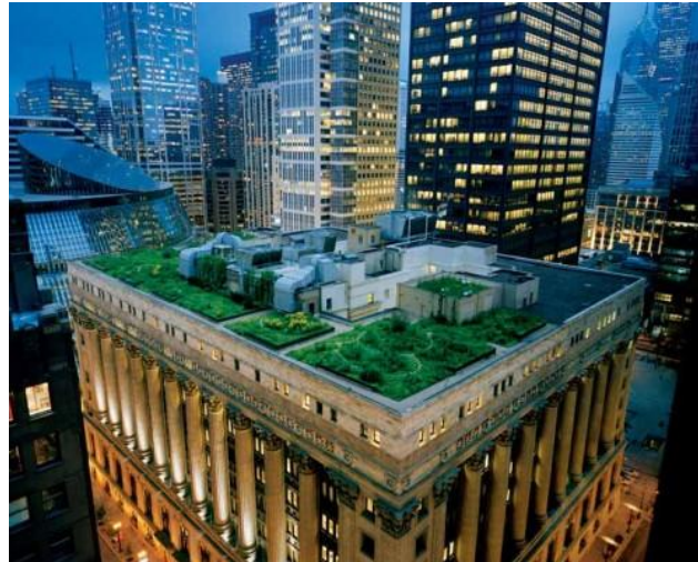
Figura No. 48 cubierta ajardinada
