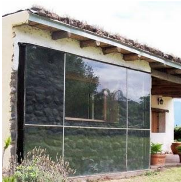
Figura No. 49 Aplicación de Muro Trombe
