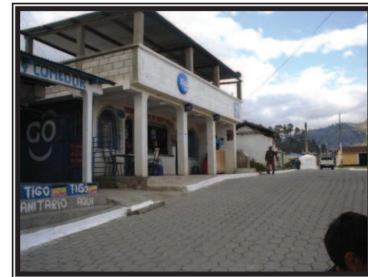
FOTOGRAFÍA 3: Utilización de sistemas constructivos no acordes a las del lugar.
