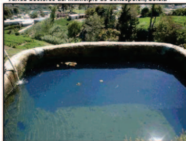
Fotografía Tanque de Miniriego Varios Sectores del municipio de Concepción, Sololá
