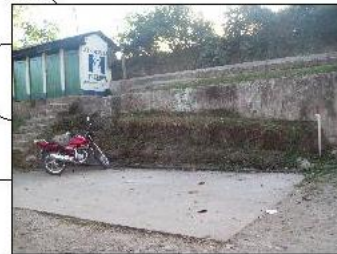
FOTOGRAFIA 15 FOSA SÉPTICA EXISTENTE
