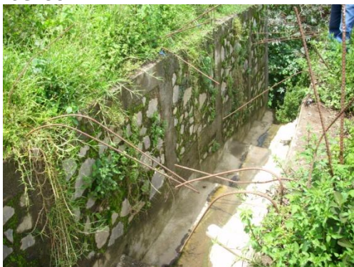
FOTOGRAFÍA 47. Canal de desviación del río Yatzá.
