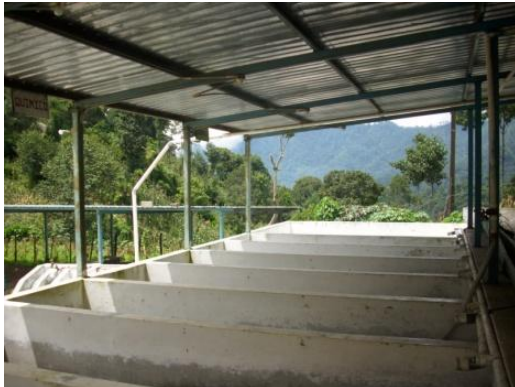
FOTOGRAFÍA 52. Tanques de fermentación, con una cubierta de lámina de zinc, costaneras y columnas de acero.
