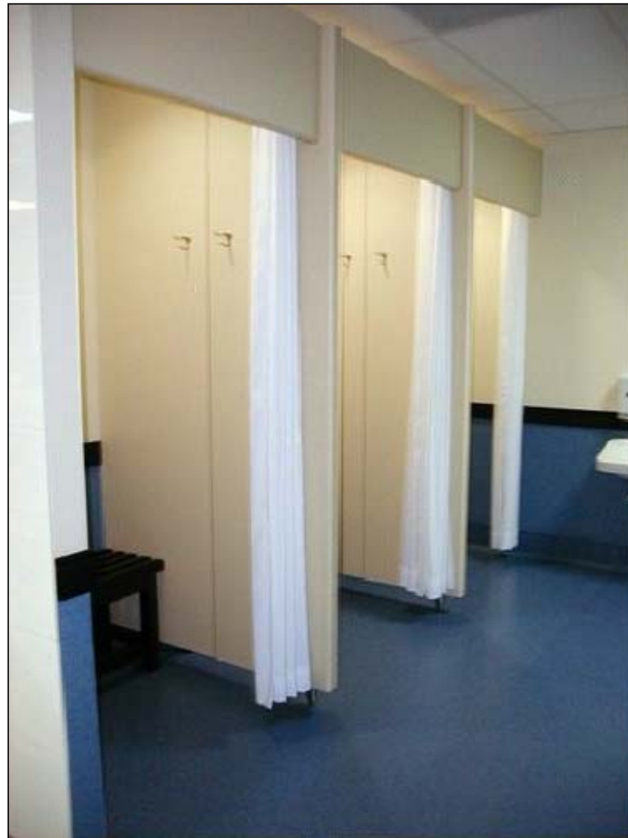
VISTA DEL AMBIENTE CON LOS TABIQUES TERMINADOS
