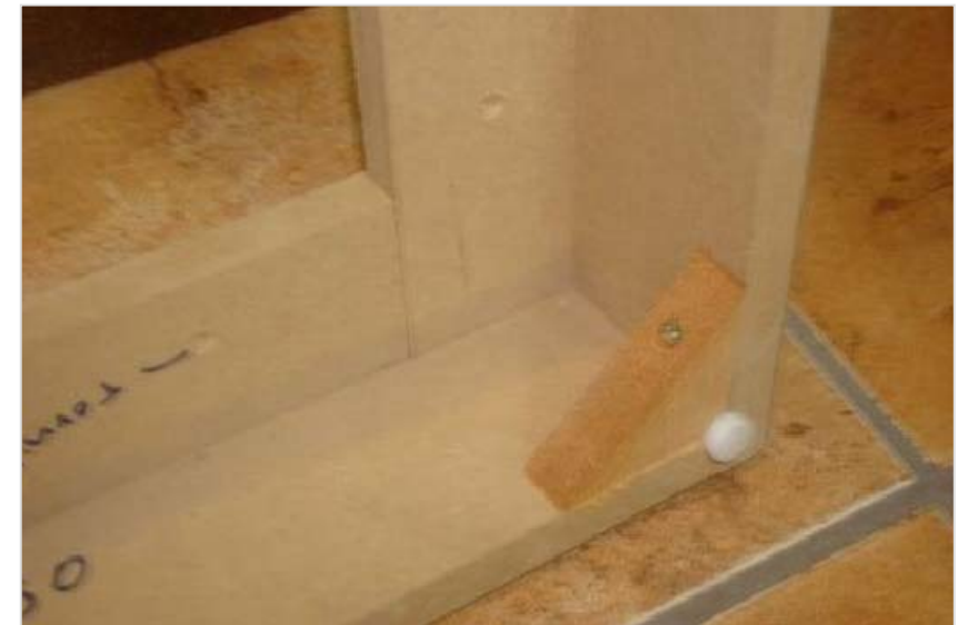
DETALLE DEL DESLIZADOR Y REFUERZO EN ESQUINA
