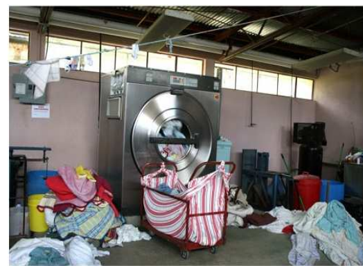
Foto No.11: Lavandería
