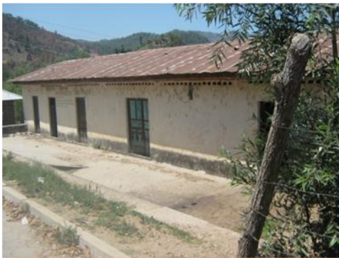
IMAGEN 2, FACHADA FRONTAL Fuente: propia
