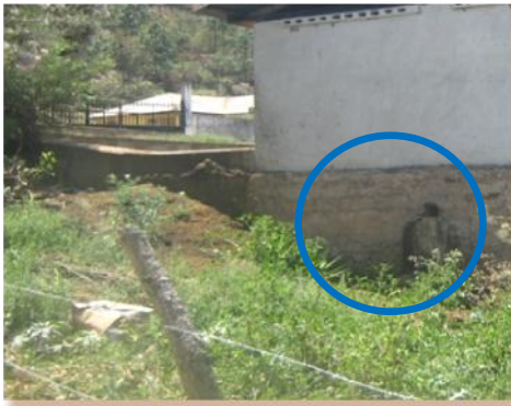
IMAGEN No. 6, DRENAJES Fuente: propia
