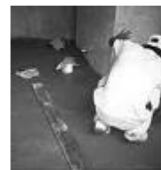
Pisos de Concreto remolineado
