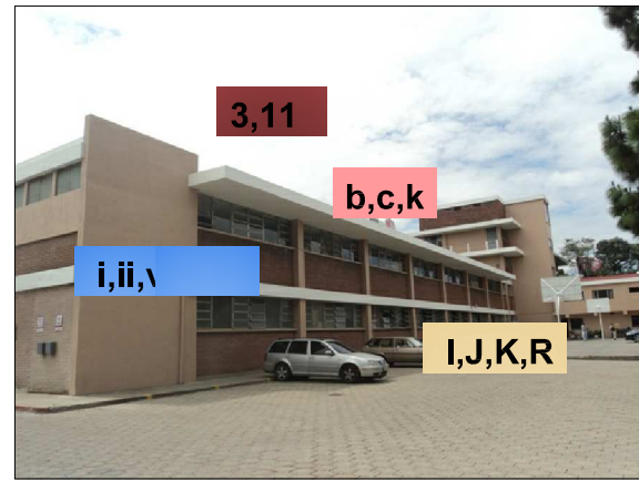
Fotografía No. 2 FACHADA SUR ESTE, INTERNA Autor: Dunia Mariela Navarro Mérida
