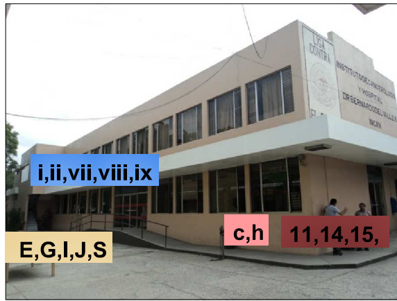
Fotografía No. 1 FACHADA ESTE, INGRESO PRINCIPAL Autor: Dunia Mariela Navarro Mérida
