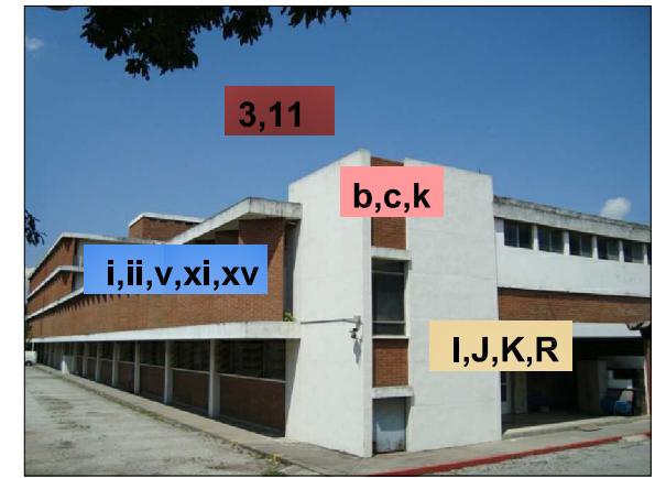
Fotografía No. 4 FACHADA SUR OESTE Autor: Dunia Mariela Navarro Mérida
