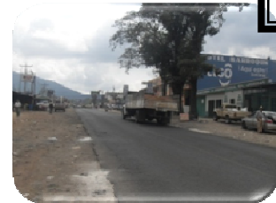
FOTOGRAFÍA No.9 JORGE ORELLANA 23 DE FEBRERO DEL 2010 VISTA DE CARRETERA A EL SALVADOR
