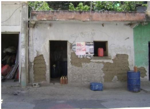
Fotografía No.8: Gasolinera Improvisada, local donde se comercializan combustibles sin las mínimas normas de seguridad, poniendo en peligro latente a la población (Fuente: Captura Propia).
