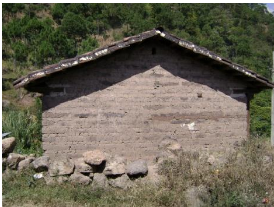
Fotografías de la No.13 a la No. 16: Viviendas tradicionales de Colotenango, utilización de adobe, teja y madera como materiales constructivos. (Fuente: Captura Propia).
