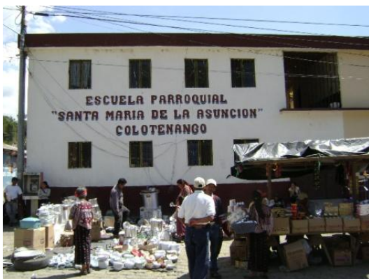
Fotografía No.9: Actualmente existen únicamente dos Edificios Educativos en el casco urbano del municipio, los cuales son insuficientes para la demanda educativa (Fuente: Captura Propia).
