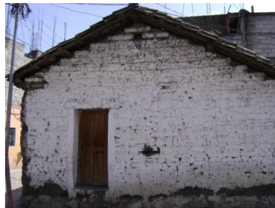
Fotografías de la No.13 a la No. 16: Viviendas tradicionales de Colotenango, utilización de adobe, teja y madera como materiales constructivos. (Fuente: Captura Propia).
