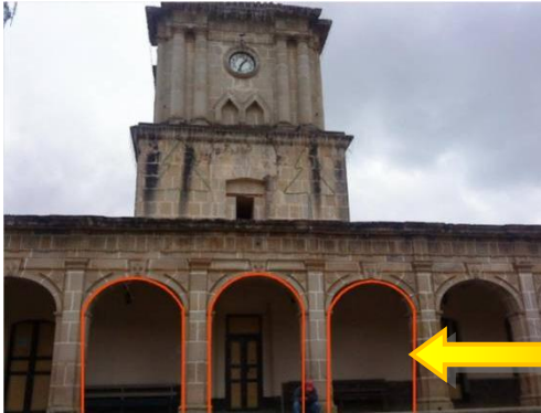
Imagen No. 26: Arcada del Palacio Municipal de Tejutla. Fuente: Diagnostico Municipal. Modificado: Wendy Per
