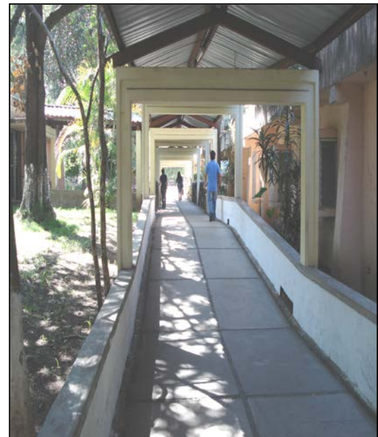
Área de pasillo
