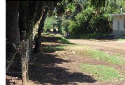
Foto No. 09 ALCANTARILLADO
