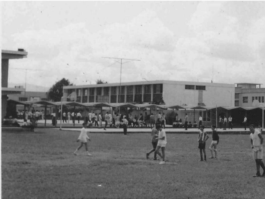
Fotografía No. 9 En la fotografía se ve ya la parte construida entre los años 1964 a 1967. Las aulas desaparecen del sector y da paso a las nuevas instalaciones de la residencia de los hermanos Maristas. Los caminamientos techados con un tratamiento especial en su diseño de láminas plegadas, con tubos metálicos esbeltos, que hacen de columnas fundidas, y dan esa sensación de espacio abierto. Archivo RFM.
