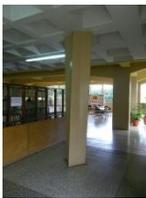
La primera de las gráficas muestra las vigas transversales en terraza. La segunda detalla la ubicación de las columnas que es de 6.00 m. a ejes en un sentido y de 9.63 en el otro. Se muestra la forma de la columna, y se ve que en el área de laboratorios la losa es nervurada. En la tercera fotografía se muestra como es la columna de forma irregular.
