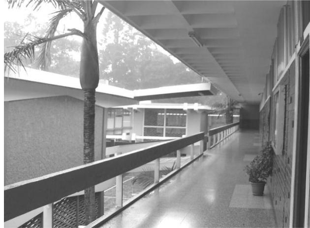
Fotografía No.11 Tomada desde la entrada a sala de profesores en el segundo nivel, en la misma se muestra el uso del aluminio, como elementos sustentante de la baranda.
