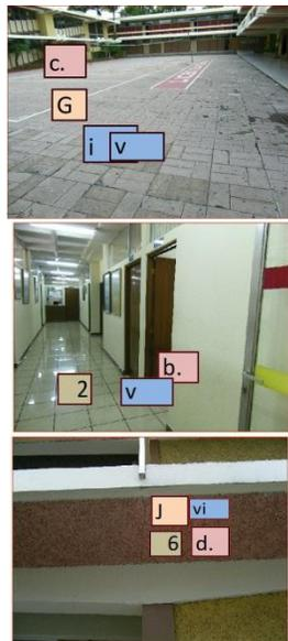
Las principales patologías están dadas en los pisos, unos son por erosión de lluvia, más el uso de las áreas, como se muestra en la primera gráfica de arriba hacia abajo; en la segunda se muestra que en una remodelación se colocó piso cerámico sobre el piso de granito; en la tercera grafica se muestran las fisuras que se encuentra en una de las barandas y que se extiende sobre la losa.
