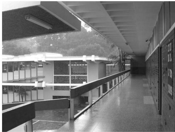
Fotografía No.15 Detalle de la losa nervurada.
