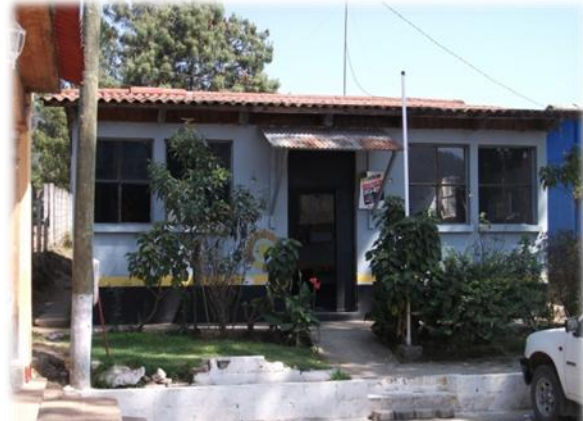
7 Subestacion De La Policia Nacional Civil. Fuente: Fotografía Propia 2010
