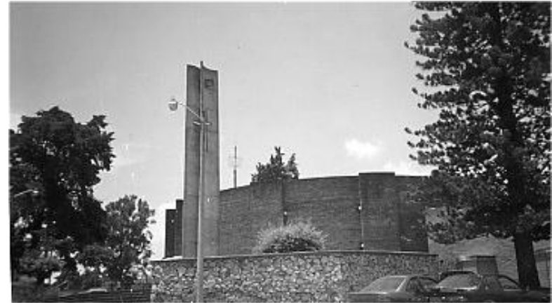
Vista general del templo "San Judas Tadeo", localizado en la 10 Calle 1-35, zona 14.
