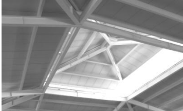
No.51 Elaboración: Propia. Febrero 2010. Detalle de Cubierta.
