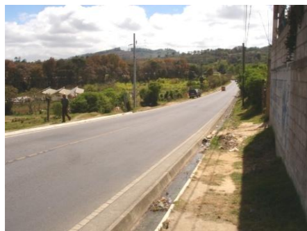
Imagen No. 26 Carretera hacia Guatemala Fuente: Propia Año: 2010
