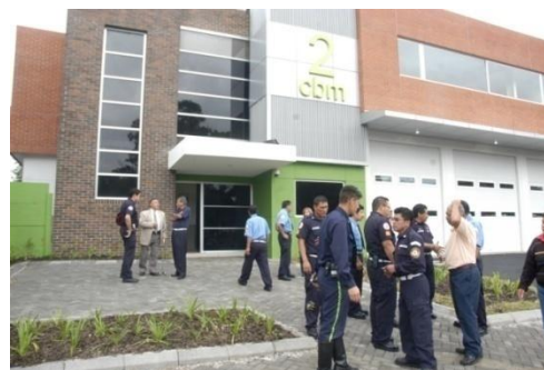
Imagen No. 38 Ingreso Principal Fuente: Tu Muni, 2010
