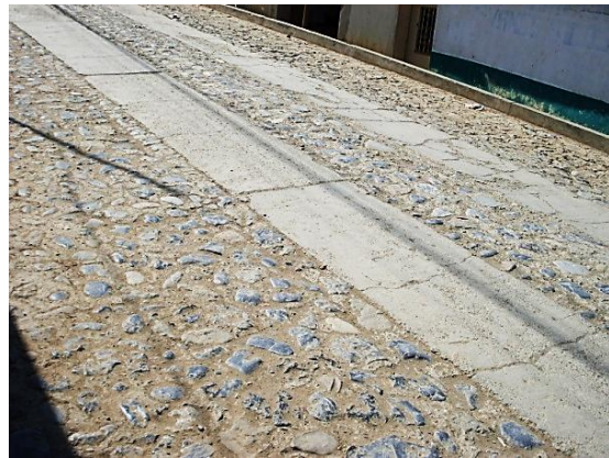
Fotografía No. 32. Pavimentación de concreto y piedra Fuente: Elaboración propia, 2010
