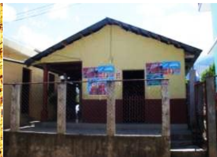
Fotografía No. 20 Vivienda de Adobe.
