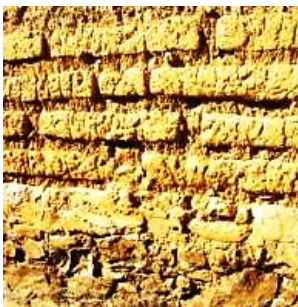
Fotografía. No.19 Adobe.
