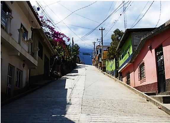
Fotografía No.31. Pavimentación de concreto Fuente: elaboración propia, 2010
