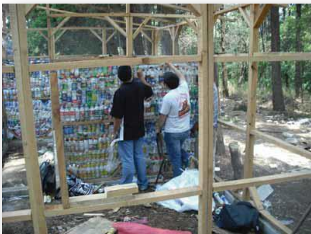
Fotografía 28. Estudiantes de la Facultad de Ingeniería de la Universidad de San Carlos de Guatemala realizando pruebas en los muros realizados después de 21 días. Fuente: Revista "Contrición" del Movimiento Pura Vida
