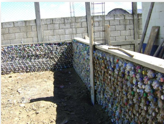
Fotografía 26. Levantado de Muro de eco-ladrillo hasta la Solera intermedia Realizado dentro de la Escuela Oficial Mixta de San Francisco, Totonicapán ejecutado por EPS 2010-2 Fuente: Propia
