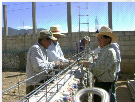
Fotografía 48 Armado de Solera Intermedia. Fuente: Propia
