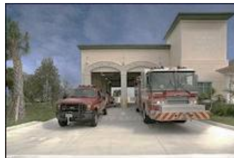
Fotografía 34 Fachada del departamento de bomberos de Everglades. Broward Fuente: Ian Nestler, AIA
