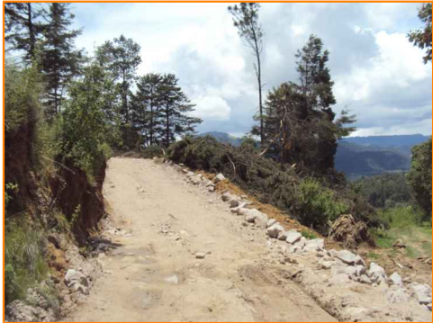
Fotografía 54 Condición actual del ingreso al terreno Fuente: Propia.
