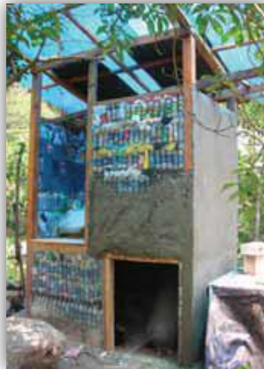
Fotografía 5. Proyecto Eco-baño, Santa Clara la Laguna. Fuente: Revista Pura Vida, Instructivo de Construcción, Pág. 9
