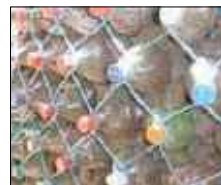
Fotografía 28. Ejemplo del amarre con pita plastica en eco-ladrillos colocados verticalmente Fuente: Universidad de India
