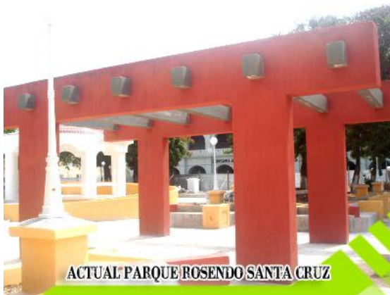
Fotografía 3: PÉRGOLAS -Fuente: www.mijutiapa.com - Modificado por: Wilfredo Úbeda - Fecha: junio 2011
