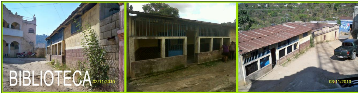
Fotografía 14-Biblioteca Municipal-Autor: Wilfredo Ubeda
