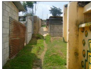
Fotografía No. 8 Mala visual Muros colindantes con viviendas particulares
