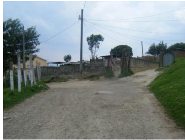
Fotografía No.10 Red de aguas negras
