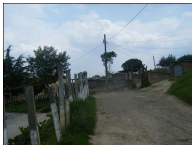
Fotografía No.11 Red de aguas negras
