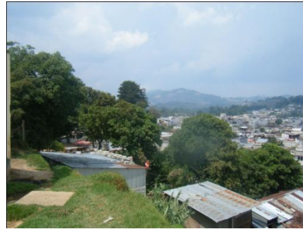
Fotografía No.4 Colindancia Poniente (talúd)
