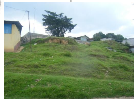
Fotografía No.4 Colindancia Oriente (talúd)
