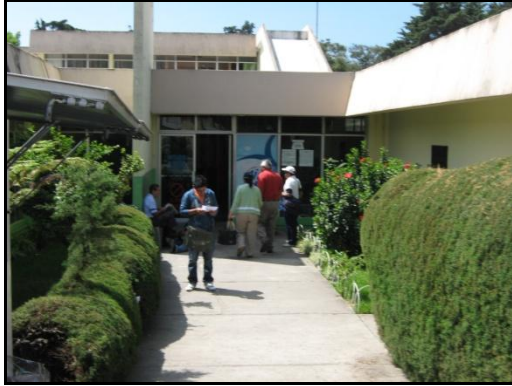
Fotografía No. 10 Fuente: Sofía Wug, 2010. La Fotografía indica construcciones Existentes
