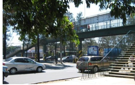
Fotografía No. 23 Fuente: Sofía Wug. 2010. La Fotografía indica equipamiento urbano (Pasarela)
