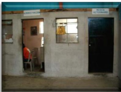
Fotografía No. 10 las oficinas administrativas son afectadas por el área de faenado, debido a la mala ubicación.
