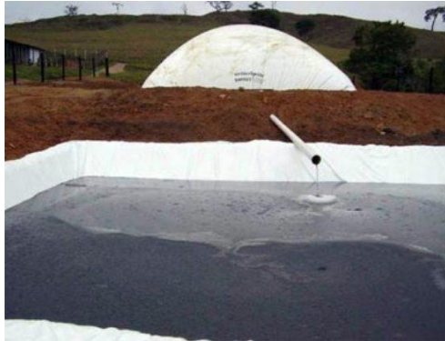
Fotografía de un sistema aeróbico por medio de lagunas aireadas.
