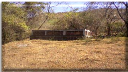
Fotografía 33: Pozo de agua, dividió en dos pero éste se encuentra en abandono. 14
