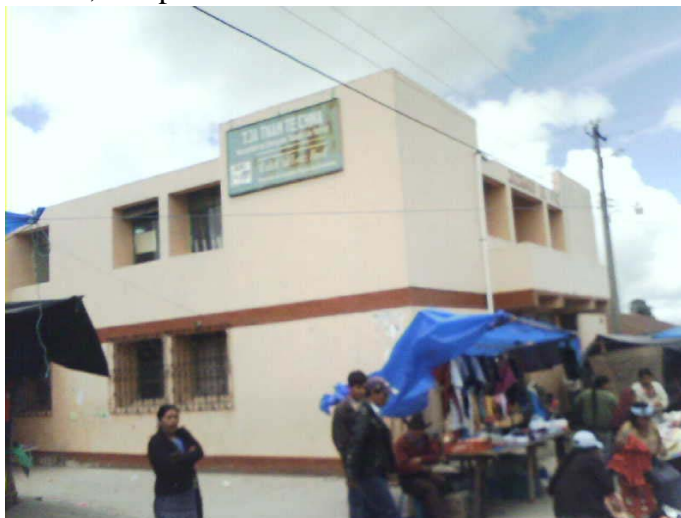
Fotografía No. 2: Actual edificio Municipal de Concepción Tutuapa, San Marcos. Fuente: Heber Nava
