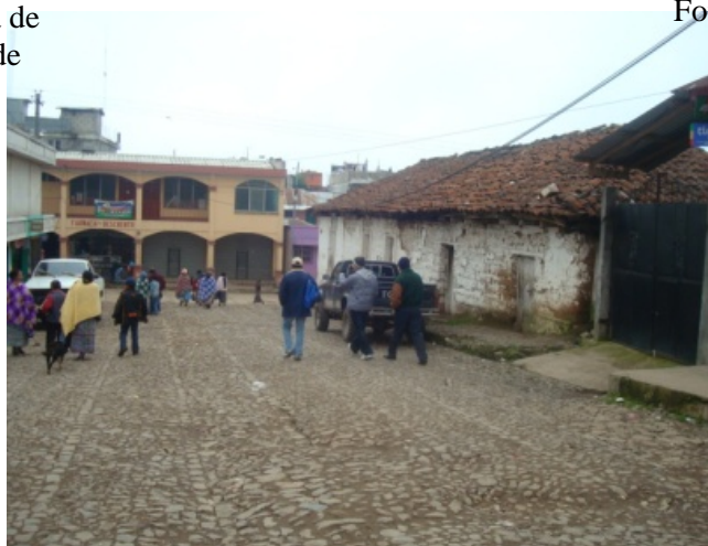
Fotografía No. 9, Vivienda de Adobe, techo de Teja. Fuente: Propia
