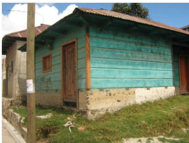
Fotografía No. 7, Vivienda de Madera, techo de lamina de zinc. Fuente: Propia
