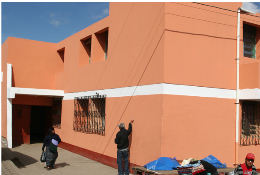
Fotografía No. 11: Edificación actual de la Municipalidad de Concepción Tutuapa, San Marcos. Fuente: propia
