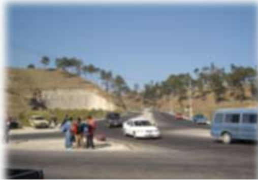
Fotografía No.22 Punto de Conflicto Vehicular Entrada a Quetzaltenango
