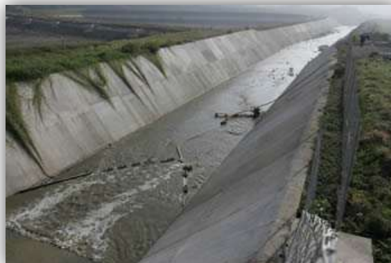
Fotografía No.21 Aguas Negras
