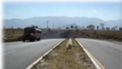
Fotografía No.23 Punto de Conflicto Vehicular Entrada a Quetzaltenango
