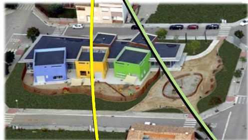
Fotografía 11, diseño con distribución dinámica. Fuente: http://www.arquimaster.com.ar/galeria/obra55.htm
