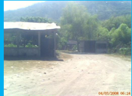
FOTOGRAFÍA No.5 HERBERT COP 2010 MUESTRA QUE EN LA ENTRADA DEL TERRENO EXISTE UNA CONSTRUCCION ABANDONADA Y DETERIORADA
