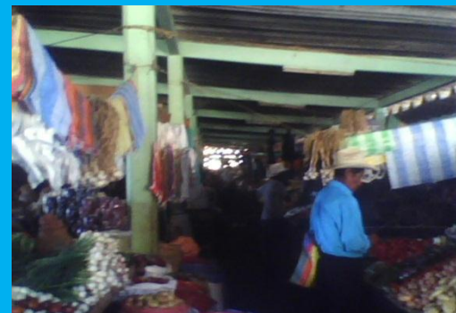
FOTOGRAFÍA No.3 HERBERT COP 2010 EN LA PARTE CENTRAL SE ENCUENTRA UNA CUBIERTA DE LAMINA DE ZINCK CON UNA ESTRUCTURA DE MADERA, CON UN ALTURA DE PISO A CIELO DE 2.20 METROS.
