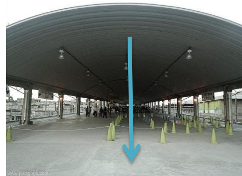
FOTOGRAFIA No.21: http://todopormiguate.blogspot.com/2007/11/opinin-urbe-el-transmetro-en-toda-la.html AÑO 2010. UBICACIÓN DE COBERTURA DE LA PARADA INICIAL DE CENMA. DANDO UN ENFASIS A LA ALTURA UTILIZADA EN ELLA.
