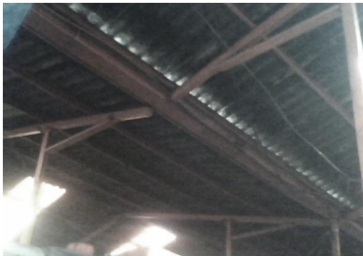
FOTOGRAFÍA No. 15 HERBERT COP, AÑO 2010. MUESTRA LA UTILIZACIÓN DE CANALES EN JUNTAS DE CONSTRUCCIÓN
