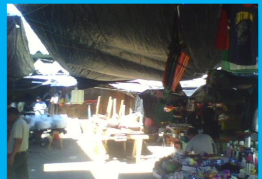
FOTOGRAFÍA No.2 HERBERT COP 2010, DEMUESTRA QUE NO EXISTE UN TIPO DE CUBIERTA FORMAL EN LA PARTE FRONTAL DEL MERCADO MUNICIPAL.
