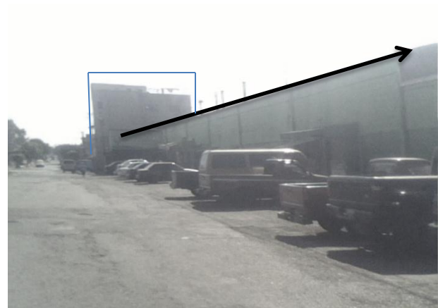
FOTOGRAFÍA No. 12 HERBERT COP, AÑO 2010, MUESTRA LA FACHADA NOR - ESTE
