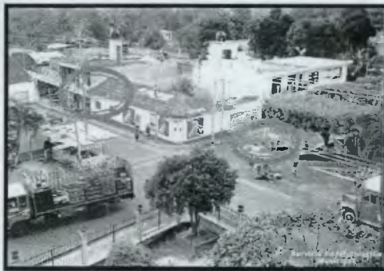
Foto No. 22 Entorno Iglesia San Felipe Apóstol Retalhuleu, Guatemala. Jackeline González, 2010
