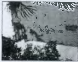
Humedad, grietas, microfisuras y deterioro.
