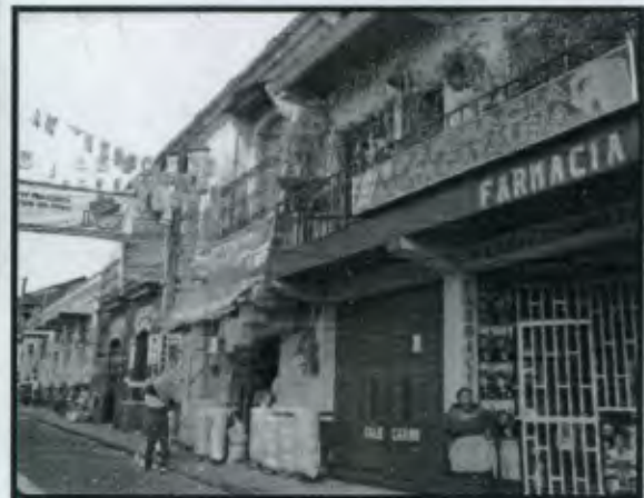
Foto No. 18 Viviendas de 2 niveles, de adobe piedra y repello, cubierta de lámina con balcones metálicos, remodeladas para comercio.
