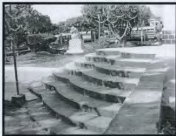
Foto No. 49 Se observa la ubicación de las gradas de ingreso al Templo de San Felipe Jackeline González, 2010
