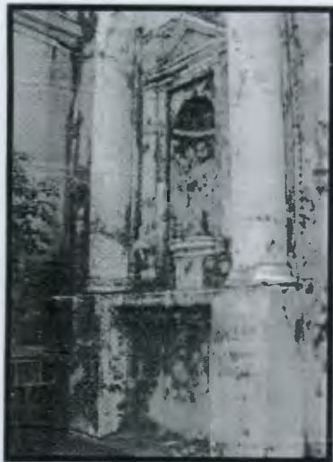
Foto 57: Humedad, desprendimiento de repello, microflora y grietas Jackeline González, 2009.
