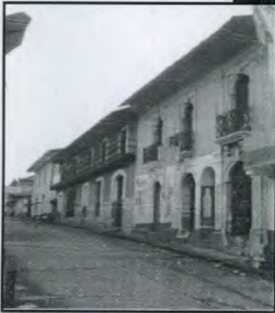
Foto No. 41. 5ta. Calle entre 3ra. y cuarta Avenida, liberar rótulos, de ventas, pintura de aceite, y otros.
