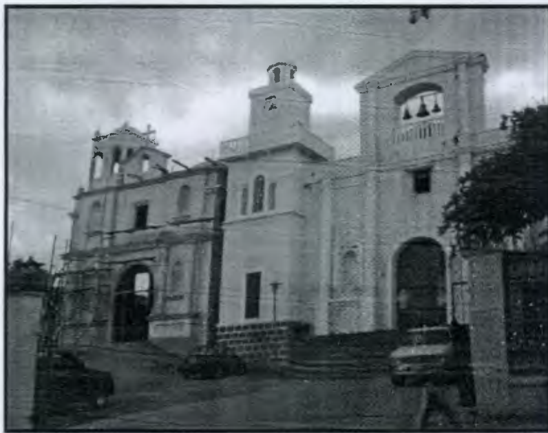
Foto No. 44 Templo San Felipe Apóstol Estado actual año 2011, construcción del nuevo templo Jackeline González
