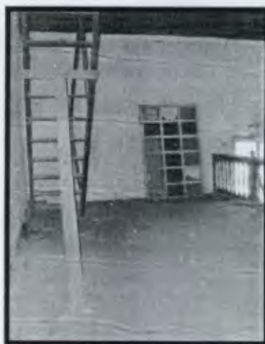
Foto 66: apoyo improvisado en módulo de gradas hacia el campanario Jackeline González, 2009.
