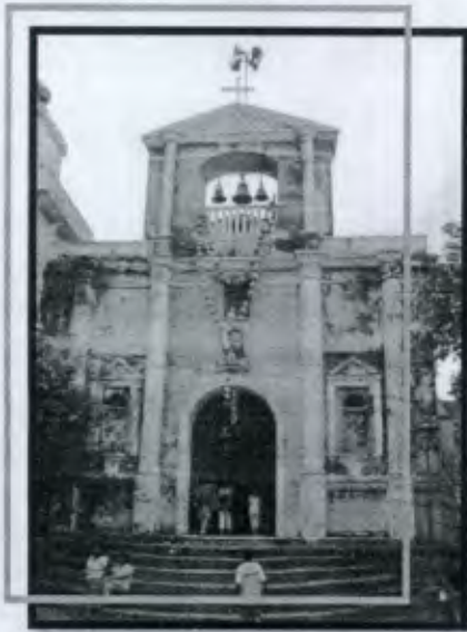
Foto No. 2 Iglesia San Felipe Retalhuleu, Elevación Frontal actual. Jackeline González, 2009.
