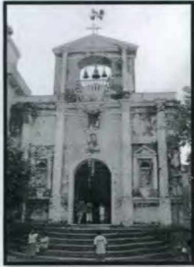
Foto 67: Humedad, grietas, desprendimiento de revello. Microflora y macroflora Jackeline González, 2009.
