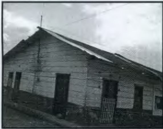
Foto No. 17 Sistema constructivo con base de ladrillo y piedra, en la parte superior estructura de madera y cubierta de lámina.
