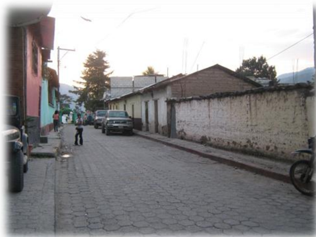
Imagen No. 16 Calle La Libertad Fuente: Elaboración Propia
