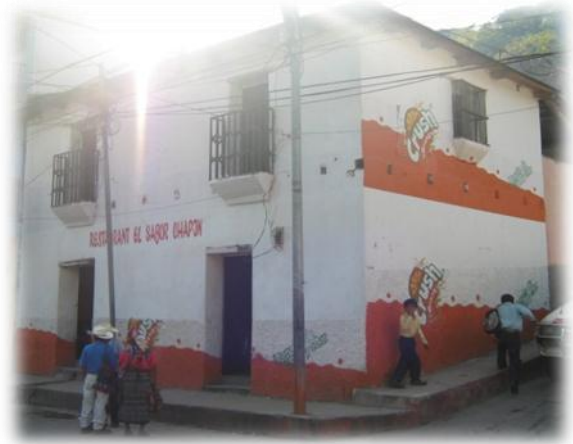
Imagen No. 26 Vivienda Particular Cayetano Rivera fuente: Elaboración propia
