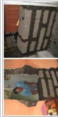
colocación de piezas de adobe
