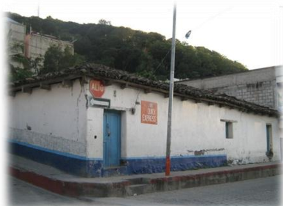
Imagen No. 31 Vivienda Particular Victor Escobar Fuente: Elaboración Propia
