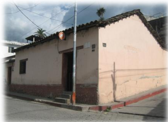
Imagen No. 30 Vivienda Particular Elvira de León Fuente: Elaboración Propia
