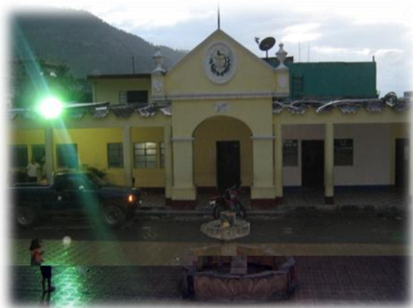
Imagen No. 34 Fachada Municipal antes de su demolición Fuente: Elaboración Propia
