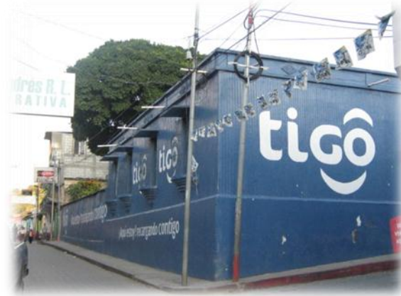
Imagen No. 32 Vivienda Particular Elizabeth Gamarro Fuente: Elaboración Propia
