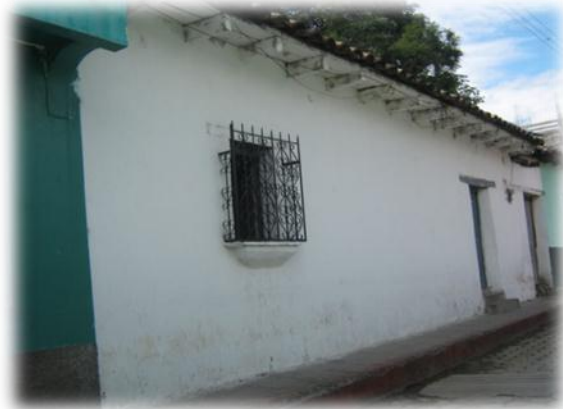
Imagen No. 29 Vivienda Particular Valeriano Pérez Fuente: Elaboración Propia
