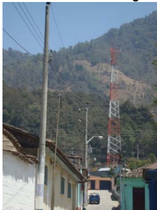
Ilustración 9: Posteado de Energía Eléctrica
