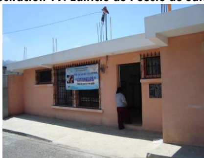
Ilustración 19: Edificio de Puesto de Salud.
