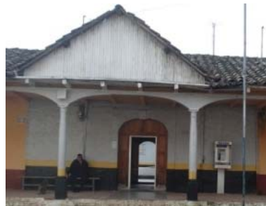
Ilustración 21: Instalaciones de la PNC en el Municipio
