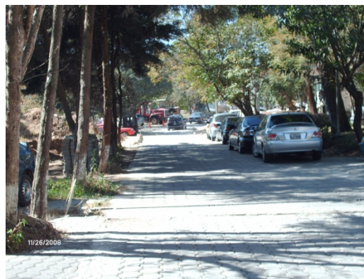
Vista de la calle que conduce hacia el área de parqueos que se construye actualmente
