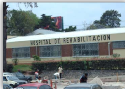
Hospital de Rehabilitación localizado en el Complejo Hospitalario Colinas de Pamplona zona 13, ciudad de Guatemala.
