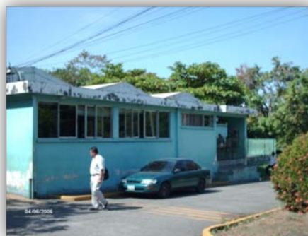
Hospital del IGSS en Santa Lucía Cotzumalguapa, Escuintla, construido en 1961
