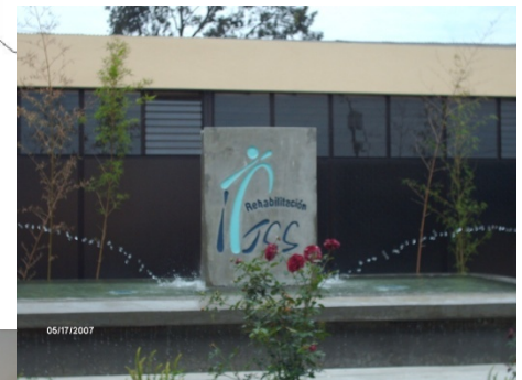
Ingreso al Área de hidroterapia
