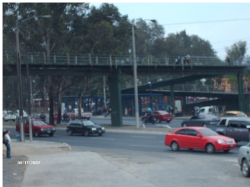
Vista del Boulevard Liberación y pasarela que comunica al Complejo Hospitalario Colinas de Pamplona
