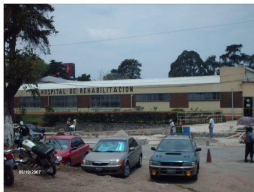
Vista Sur del terreno, donde se observa el Hospital de Rehabilitación y parqueo de empleados del lugar.
