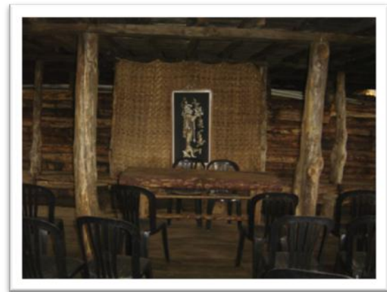
Fotografía No. 4: En estas se pueden observar que tanto el salón como el comedor están contruidos de madera las cubiertas son de lámina de zinc, toda la estructura esta realizada con troncos formando marcos rígidos, el piso está construido con tablones sin ningún tratamiento. El parque cuenta con 2 salones de eventos y 2 comedores.
