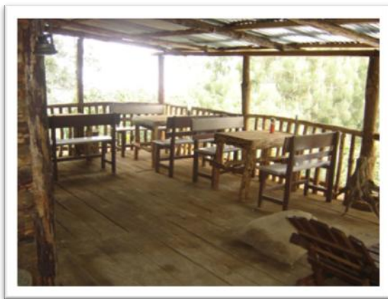
Fotografía No. 4: En estas se pueden observar que tanto el salón como el comedor están contruidos de madera las cubiertas son de lámina de zinc, toda la estructura esta realizada con troncos formando marcos rígidos, el piso está construido con tablones sin ningún tratamiento. El parque cuenta con 2 salones de eventos y 2 comedores.
