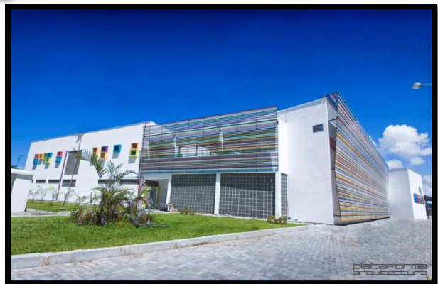
Imagen 56 Fachada Principal Fuente: http://www.plataformaarquitectura.cl
