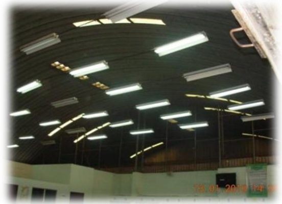
Imagen 21. Cubierta tipo EMCO, en módulo de farmacia y terapia. Fuente propia. 2010.
