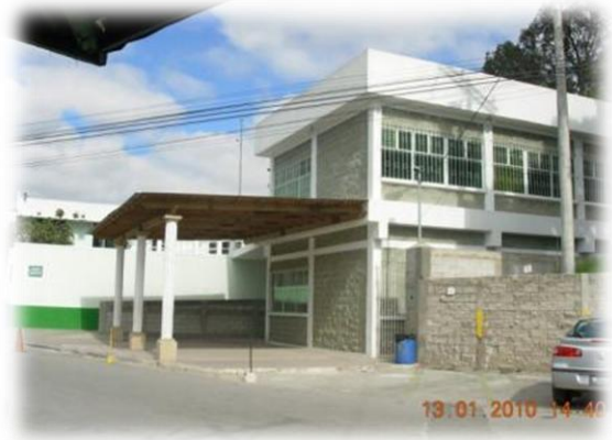
Imagen 17. Edificio Administrativo. Fuente propia. 2010.
