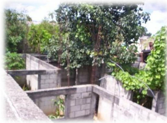
Imagen 28. Construcción sin finalizar de ampliación a Centro.
