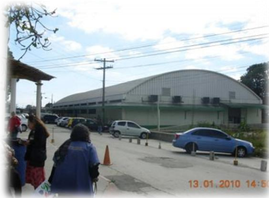
Imagen 16. Acceso vehicular y estructura en módulo de farmacia y terapia grupal. Fuente propia. 2010.
