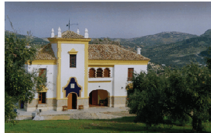
Foto No. 6 Transformación de Estación en hotel, Vía Verde de La Sierra.
