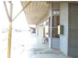
Foto No. 38 Andén de la estación.
