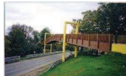
Foto No. 3 Pasarela Vía Verde Vasco.
