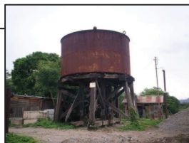
Foto No. 32 Cuarto de Maquinas con su propio tanque de agua.
