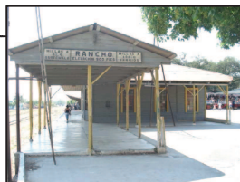
Foto No. 34 Estado actual del edificio de la Estación de El Rancho.
