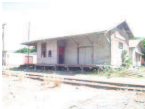
Foto No. 108 Estacion del ferrocarril de El Jícaro, punto final del tema en estudio.
