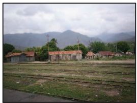
Foto No. 28 Viviendas Familiares, actualmente solo hay tres.
