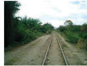
Foto No. 103 Tramo de vía previo al puente.
