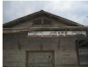
Foto No. 109 Estado actual de la estación del municipio de El Jícaro.
