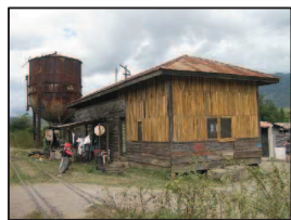
Foto No. 27 Bomba de agua y Dormitorio para maquinistas.
