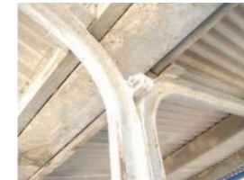
Foto No. 41 Detalle estructural de andén, construido de hierro y lámina.
