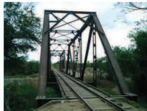
Foto No. 104 Puente original en buen estado, a pesar de los años y las inclemencias del tiempo.
