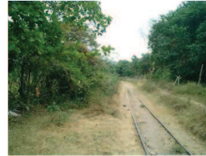
Foto No. 87 Vista de una pequeña curva ubicada al centro de la milla.
