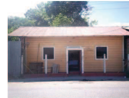
Foto No. 19 Edificación antigua localizada frente al andén de carga.
