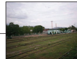
Foto No. 36 Vías de estacionamiento frente al edificio de la estación.
