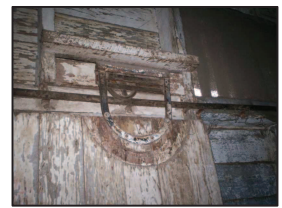
Foto No. 44 Detalle puerta de bodega.
