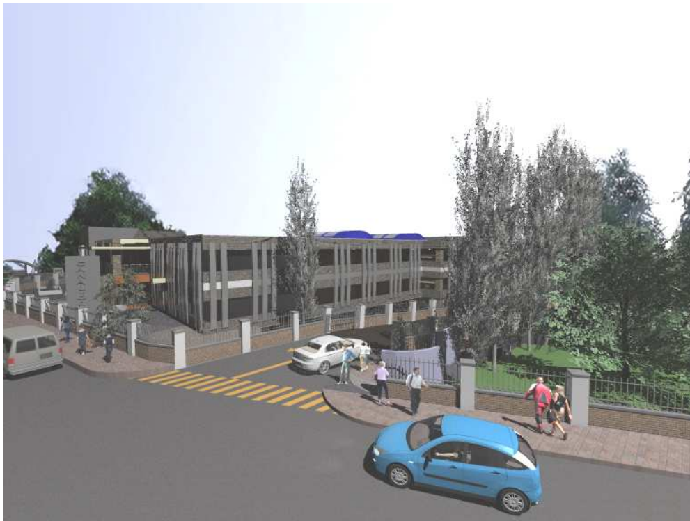
INGRESO A PARQUEO EN SÓTANO DE MERCADO
