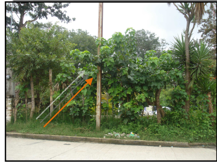
Foto No. 41. Postes de cable por televisión pagado y de telefonía cerca del terreno de la propuesta.
