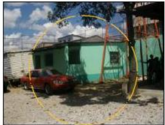
Foto No. 5 Área de Mantenimiento Fuente: Ma. De los Ángeles Girón
