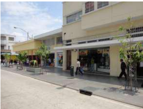
Foto No. 7. 6ta av. Zona 1. (Banqueta remodelada)
