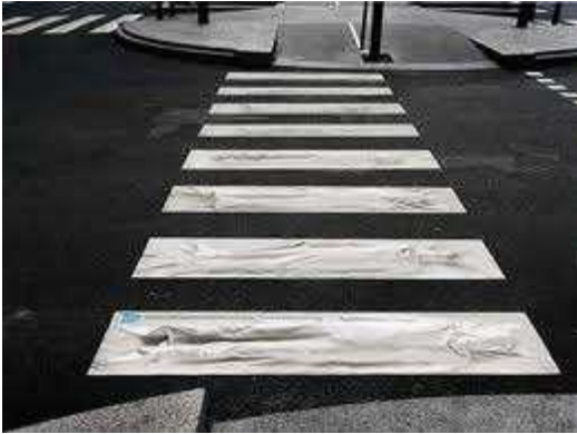
Foto No. 6. Paso de cebra para las esquinas de las calles.
