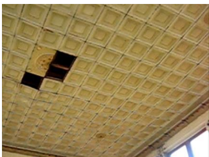
Foto No. 19. Techo del laboratorio actual.
