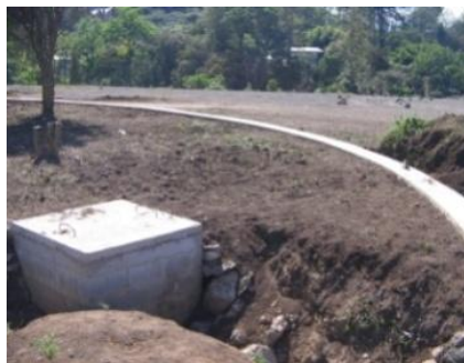
CAJAS DE DRENAJES DENTRO DEL POLÍGONO A UTILIZAR.
