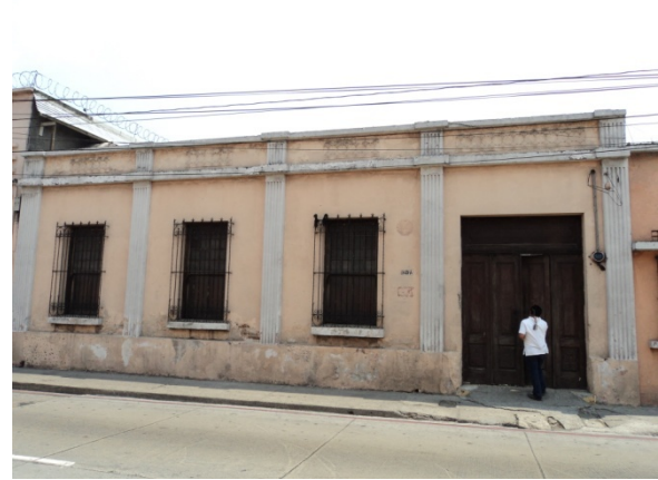
Fachada principal del inmueble.
