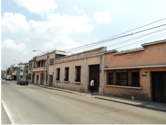
Panorámica del Entorno Urbano Inmediato.
