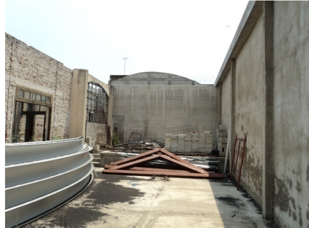
Obsérvese el área destinada para la futura propuesta de escenario.
